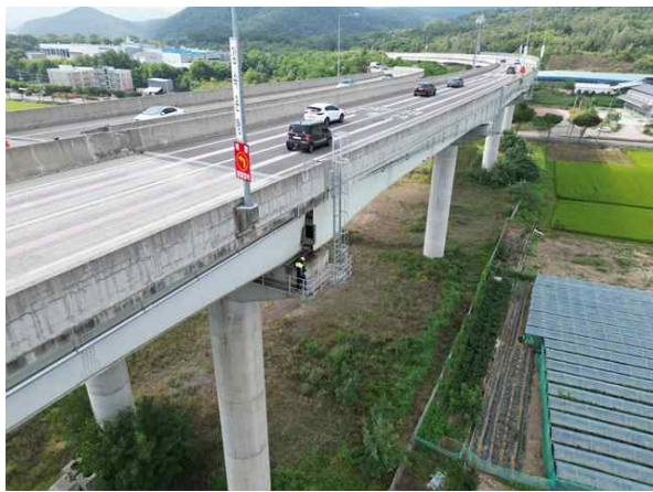
도보점검을 이용한 부재치수 현장측정
