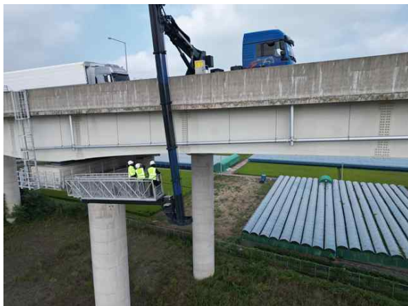
굴절작업차를 이용한 근접조사
