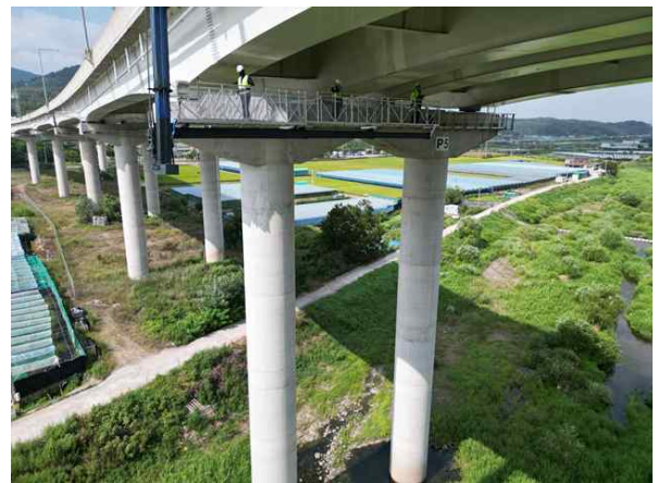
굴절작업차를 이용한 근접조사
